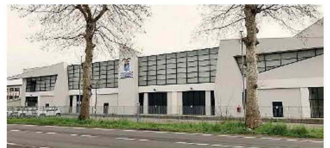
Da oltre un anno. La sede della Protezione civile provinciale, al palo
